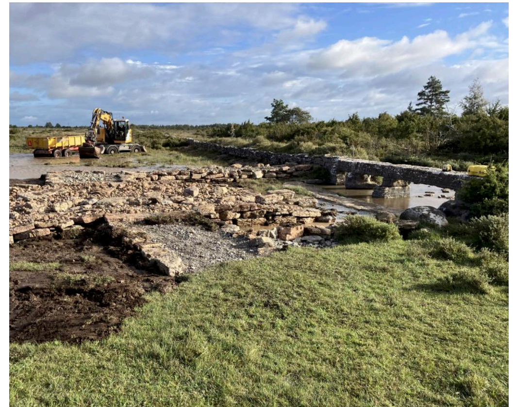
Pågående arbete i Ekelunda sommaren 2025. Foto: Mörbylånga kommun
